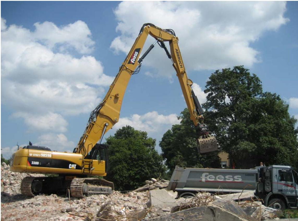
Innerhalb des Recyclingsgeländes werden die Betonanlieferungen von den Mauerwerksanlieferungen getrennt gehalten. Bei den Altbetonen, die als Ausgangsstoff für die RC-Gesteinskörnung vorgesehen waren, erfolgte nach bauphysikalischen Gesichtspunkten noch einmal eine grobe Vorabtrennung von schlechteren Betonteilen.
